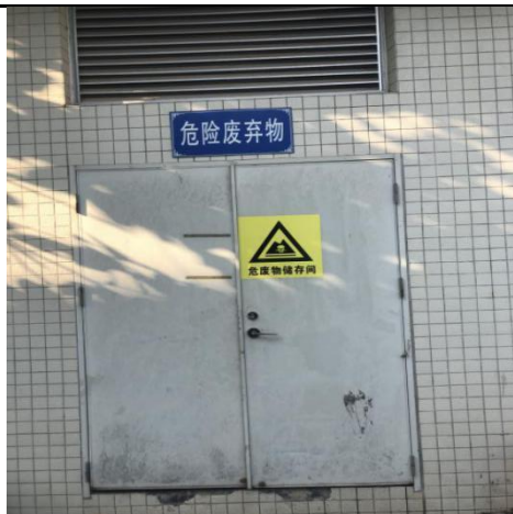
危废物储存间
